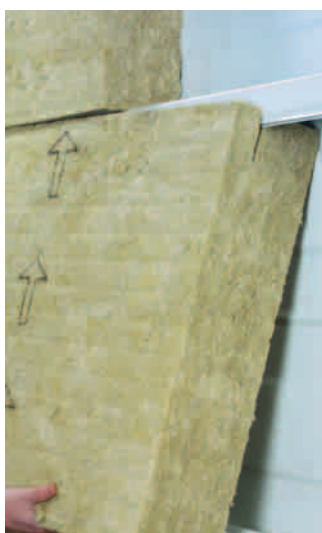
Steelrock Plus wird mit der Markierung zum Obergurt in die Kassetten eingebaut.
