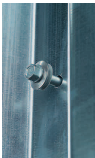
Nur die Außenschale bzw. das Hutprofil wird mit 6,5 mm vorgebohrt.
